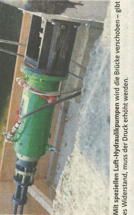
Mit speziellen Luft-Hydraulikpumpen wird die Brücke verschoben – gibt es Widerstand, muss der Druck erhöht werden.
