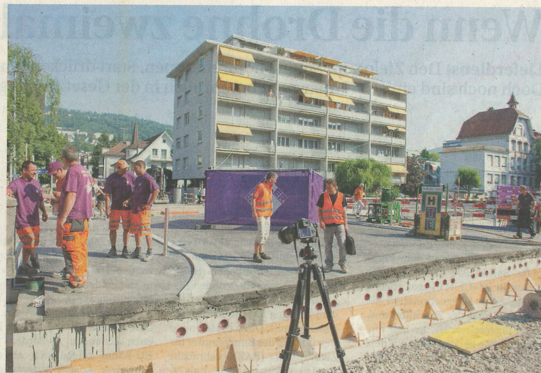
9.35 Uhr: Die Verschiebung war erfolgreich – die neue Brücke steht nun exakt da, wo vorher die alte war.
